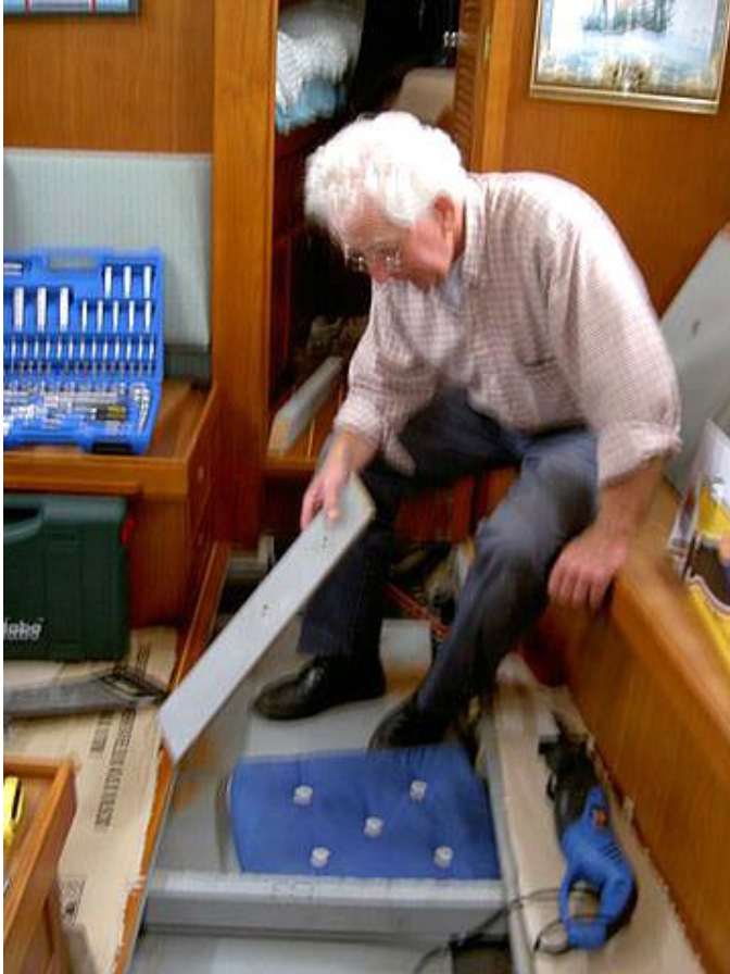
Foto 2. Het doorzagen van de vloerspanen. Aan bakboordzijde moet er zo schuin mogelijk worden gezaagd om net voldoende ruimte te krijgen om de tank eruit te kunnen kantelen en de nieuwe er weer in.
