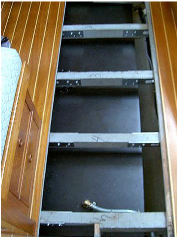
Foto 5. Het eindresultaat. De koppelplaten zijn duidelijk zichtbaar.
