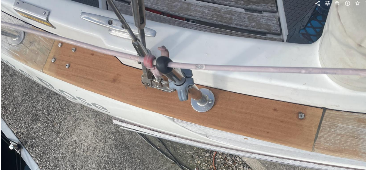
Deze kitrand is aangebracht met Window Seal
