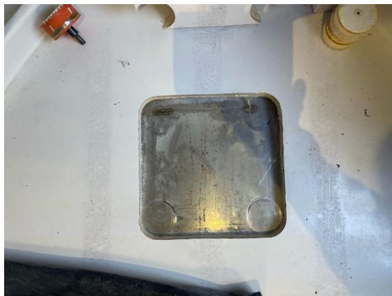
Nu langs de mal de rechte zaagstukken zagen, met multitool. Bovenkant tank komt in zicht.
