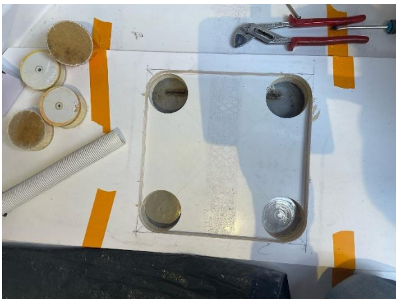
Nu langs de mal de rechte zaagstukken zagen, met multitool. Bovenkant tank komt in zicht.
