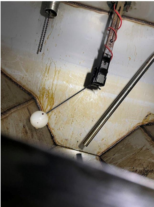
Inkijkje in het achterste deel van de tank.
