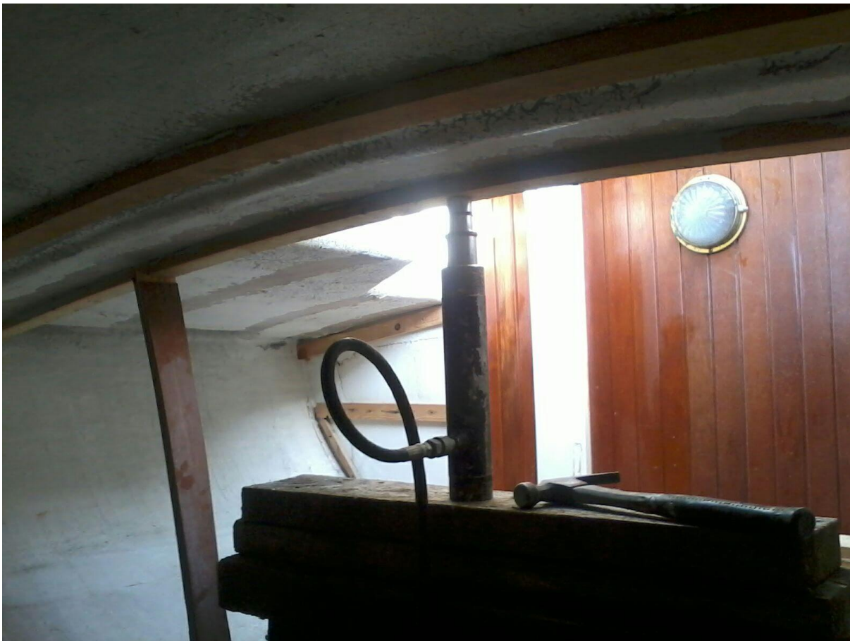
De eerste latten klemmen om de lijm te laten drogen.
