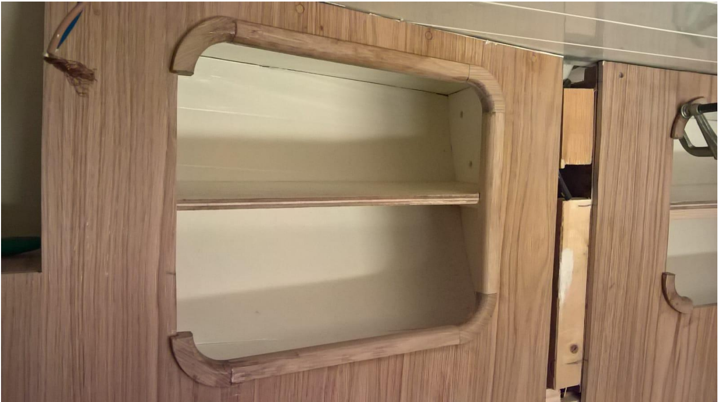
Frontjes ervoor en eerste hoekjes van afwerklathes.
