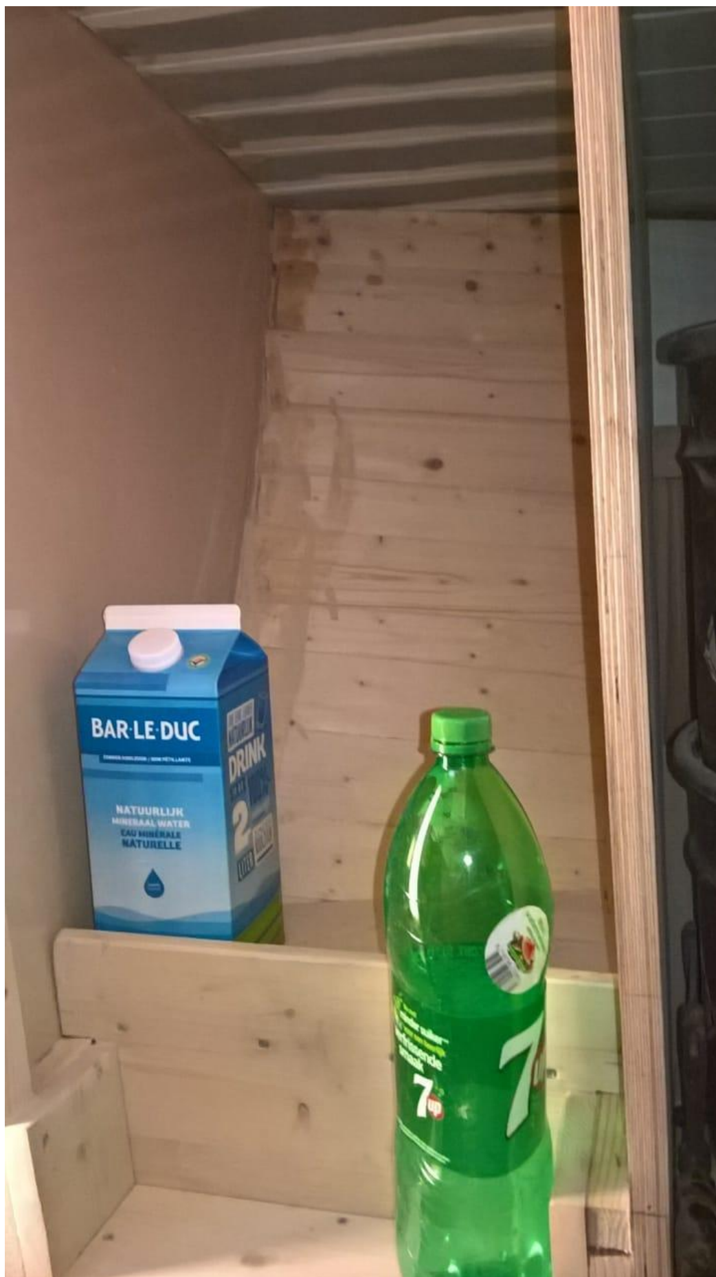
Plankhoogte bepalen van de hoge kasten
