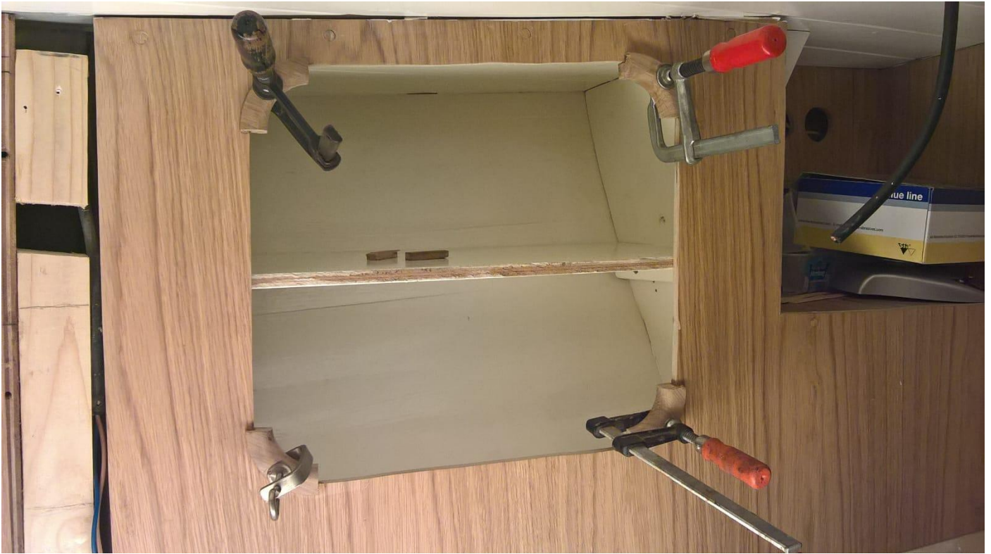
Frontjes ervoor en eerste hoekjes van afwerklathes.
